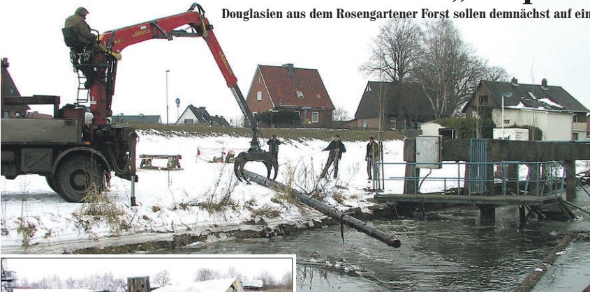
Maßarbeit mit einem Ladekran: Im Hafen von Stöckte (Landkreis Harburg) wurden die Baumstämme nach einjähriger Lagerung zur weiteren Bearbeitung aus Ufer verfrachtet
